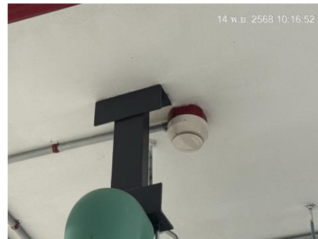
อุปกรณ์ตรวจจับความร้อน (Heat Detector)
