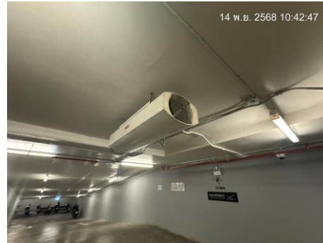
ระบบระบายอากาศพื้นที่จอดรถในอาคาร
