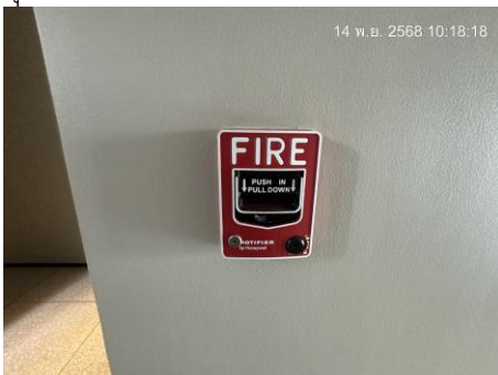
อุปกรณ์แจ้งเหตุเพลิงไหม้ด้วยมือ รูปที่ 2.1-14 ระบบการป้องกันและระงับอัคคีภัย
