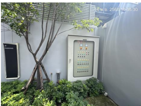
ตู้ควบคุมระบบบำบัดน้ำเสียโครงการ
