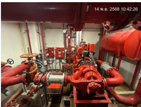
ระบบเครื่องสูบน้ำดับเพลิง (Fire Pump System)
