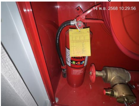
ตู้เก็บสายฉีดน้ำดับเพลิง FHC
