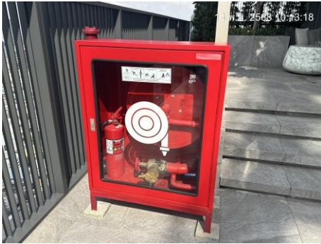
ตู้เก็บสายฉีดน้ำดับเพลิง FHC
